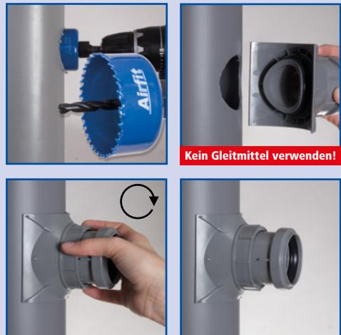
Einfache Installation: Loch bohren (rechtswinklig zur Rohrachse) Ø 57 mm, Schneidöl entfernen, mit Schleifpapier entgraten, Schraub-Abzweig aufsetzen und anziehen. FERTIG!
